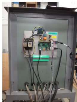
制御盤の裏にマイコンやリレーを設置
