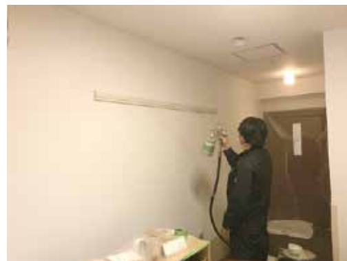
壁クロスへの施工の様子
