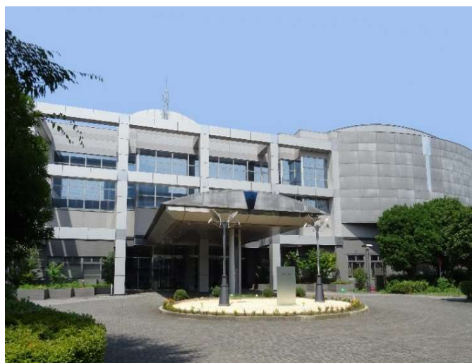
神奈川県から出資された海老名本部の建物
