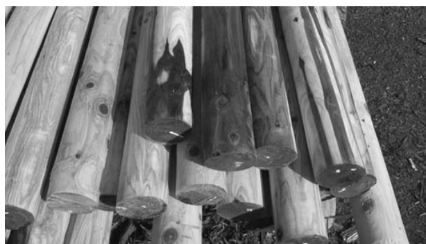
写真1 被害を受けた丸太杭
